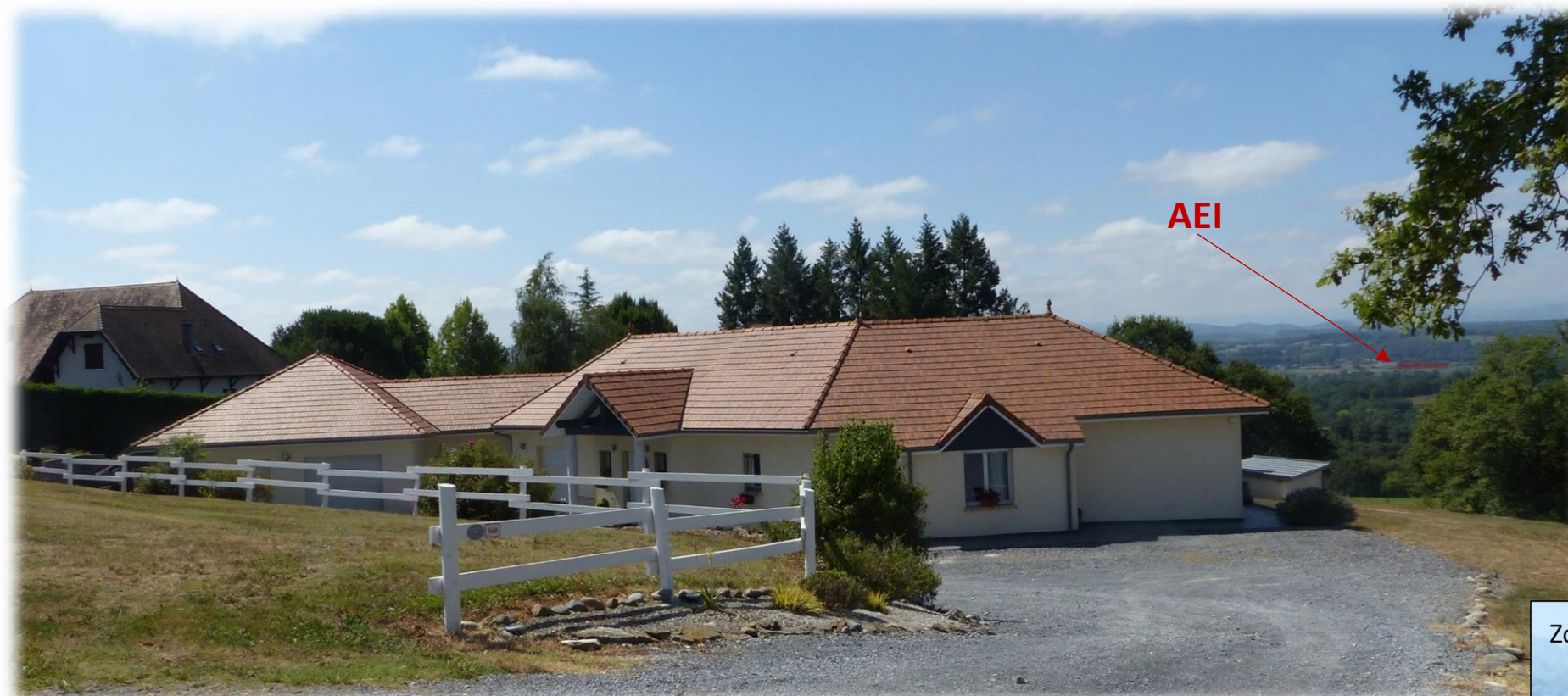
Point de vue 3 : habitation au lieu-dit « Sansoulet », à 3,31 km au nord-est de l'AEI
